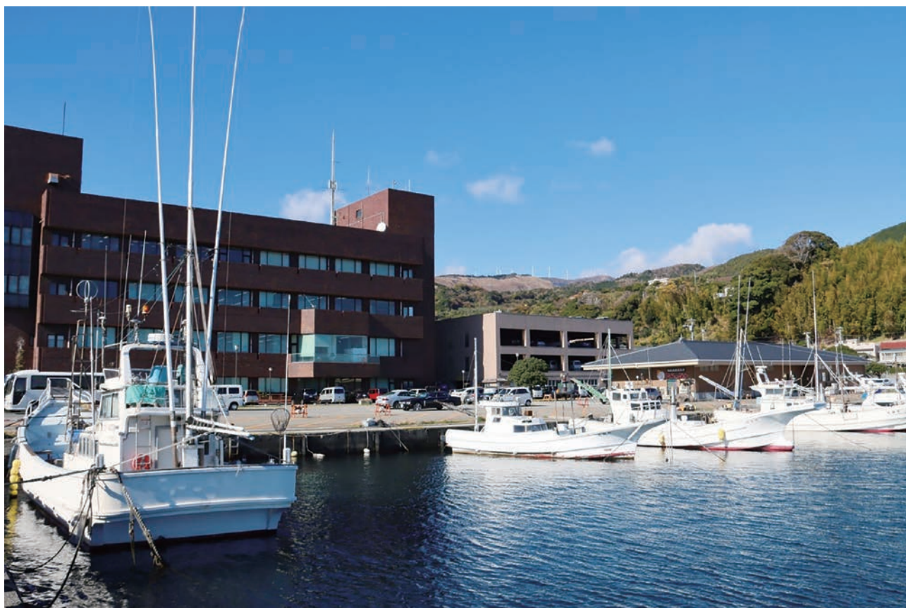
稲取港（東伊豆町）
